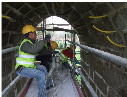
Foto 2 – Injecção de fendas
