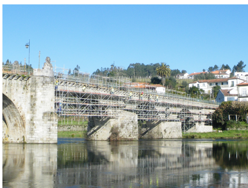
Foto 1 – Montagem de plataformas suspensas
