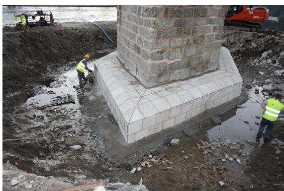
Foto 3 – Colocação de capeamento de revestimento
