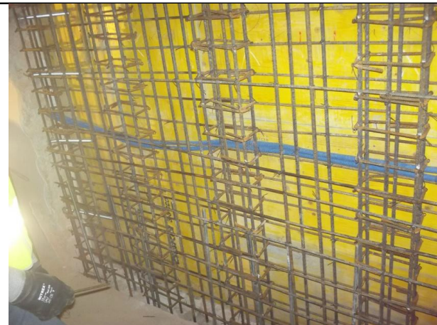
Foto 2 – Reforço em Betão Armado
